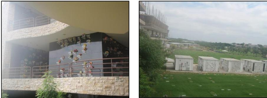
Dentro del servicio de inhumación, se encuentra la implantación de lotes, los cuales pueden ser módulos dobles o triples, que se elaboran con prefabricados de hormigón armado y se cubren con una capa de tierra sobre la cual se coloca el césped.
